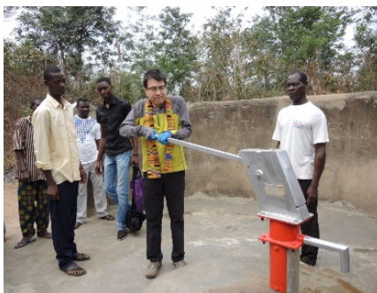
図1：井戸修理の様子（写真）
