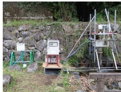
図1 マイクロ水力発電システム
