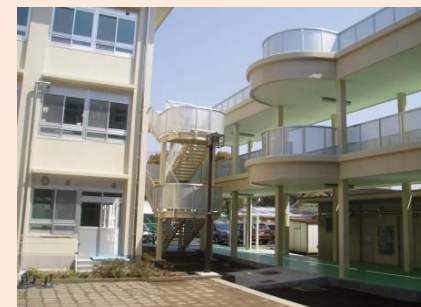
附属小学校の渡り廊下(バリアフリー対策)
