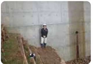
森林土木復旧工事現場にて
