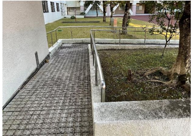
医学部講義棟正面入口 スロープ
