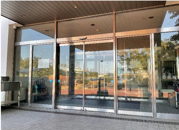
医学部講義棟正面入口 自動ドア
