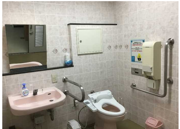
1階 多目的トイレ内部
