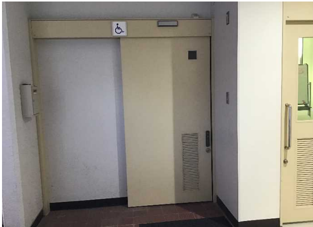
1階ATM横 多目的トイレドア
