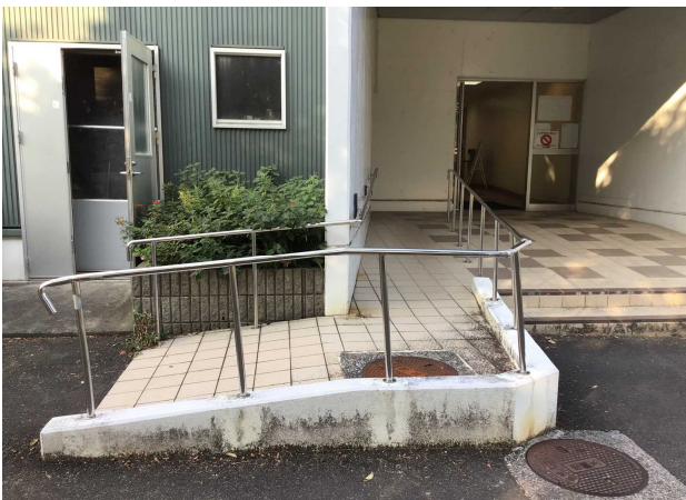
南入口スロープ
