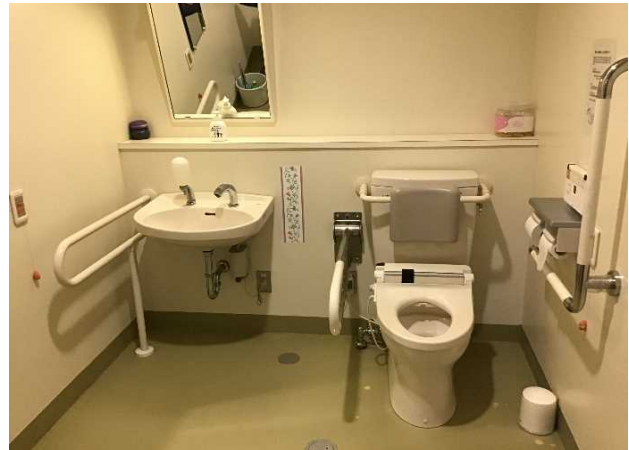
1階ATM横 多目的トイレ内部
