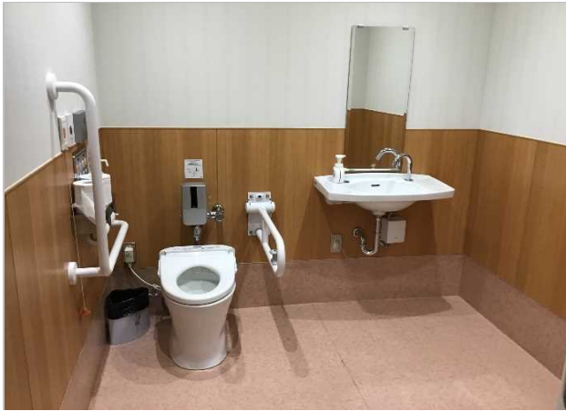
1階 多目的トイレ内部
