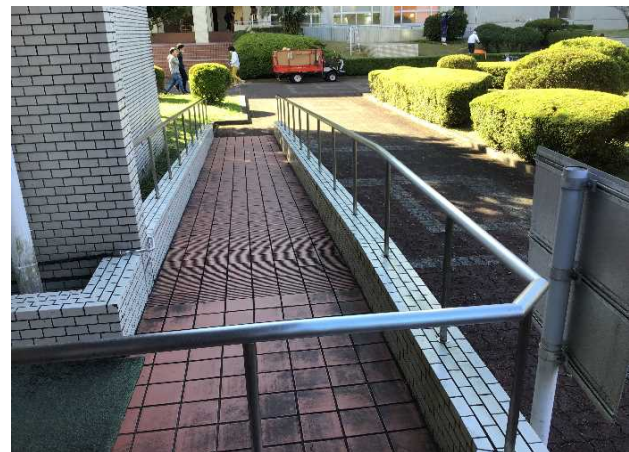
正面玄関右側スロープ
