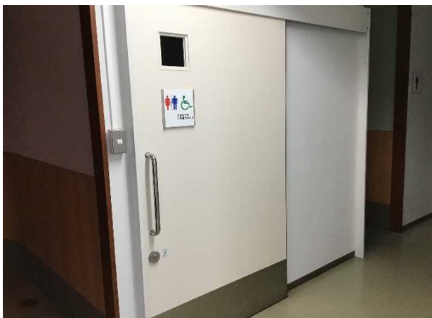
1階 多目的トイレドア
