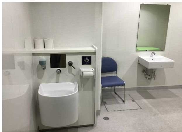
1階南 多目的トイレ オストメイト
