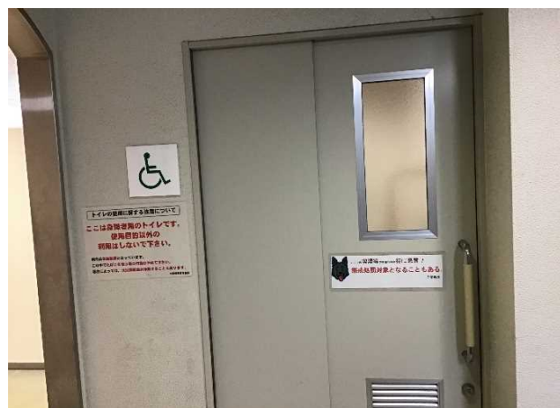
1階北 多目的トイレドア
