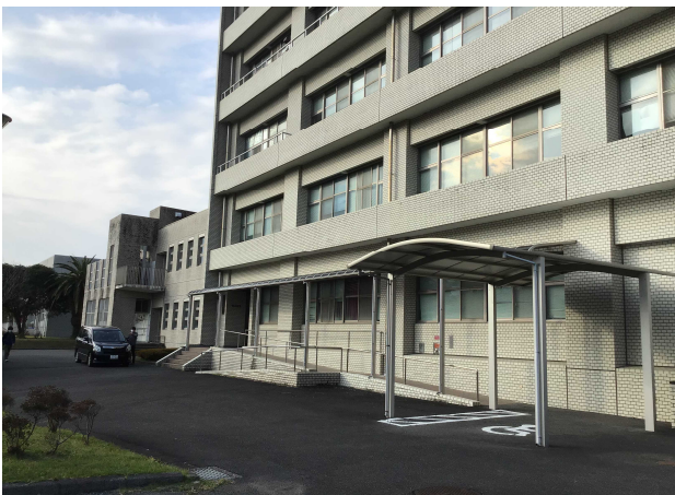
E棟駐車場一スロープ
