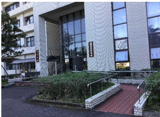
正面玄関スロープ
