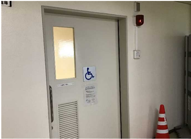
1階 多目的トイレドア
