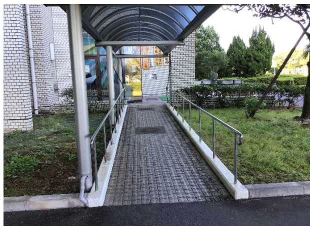
駐車場スロープ
