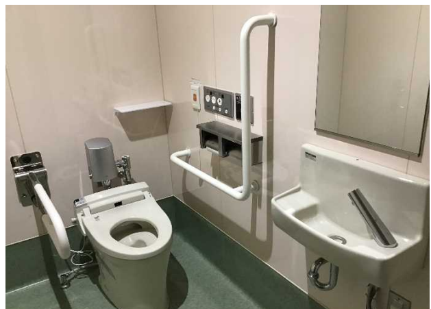
1階 多目的トイレ内部
