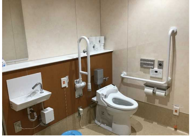
5階多目的トイレ 内部
