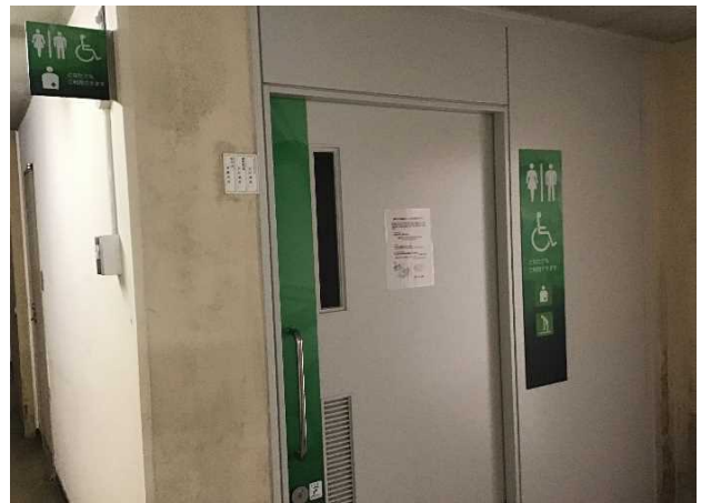
1階多目的トイレ ドア
