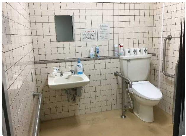
1階 多目的トイレ内部
