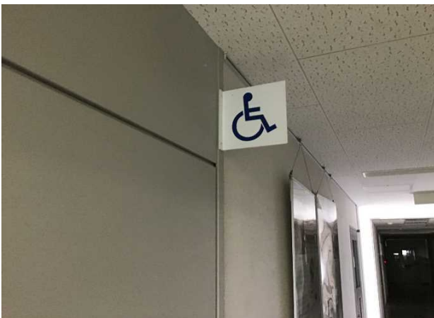
1階 多目的トイレ表示
