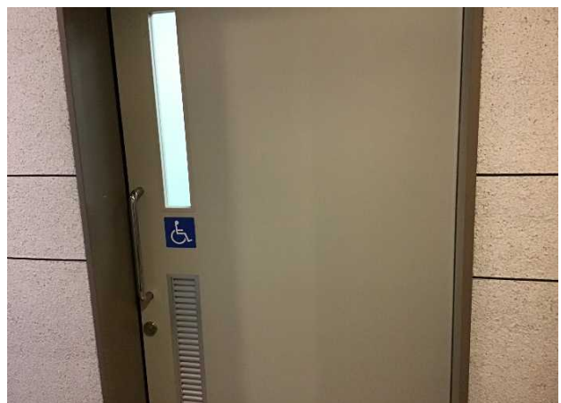
1階 多目的トイレドア
