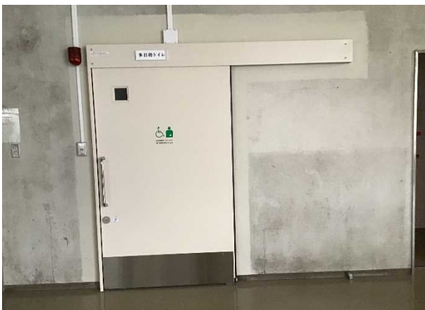
1階 多目的トイレドア
