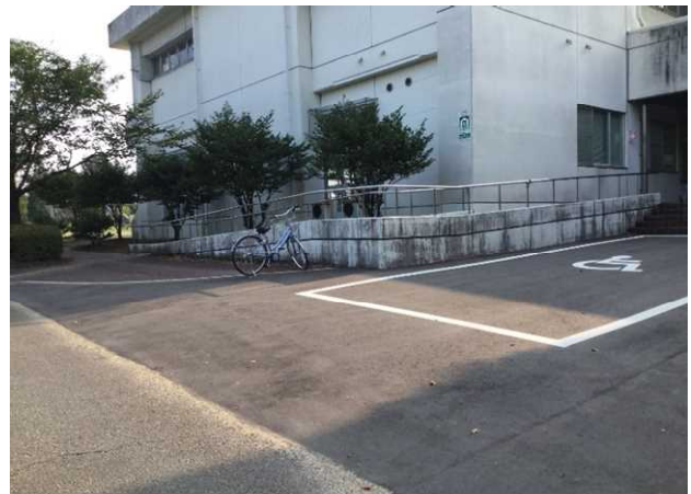
駐車場・スロープ
