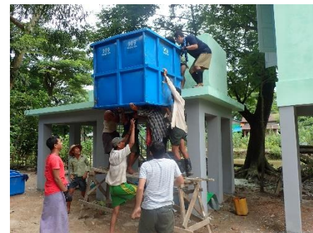
・代替水源施設設置の様子
