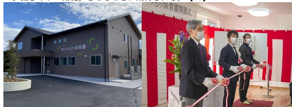
＜完成したゆにのもり保育園と、完成式典の様子＞
