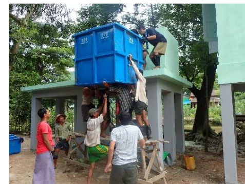
・代替水源施設設置の様子
