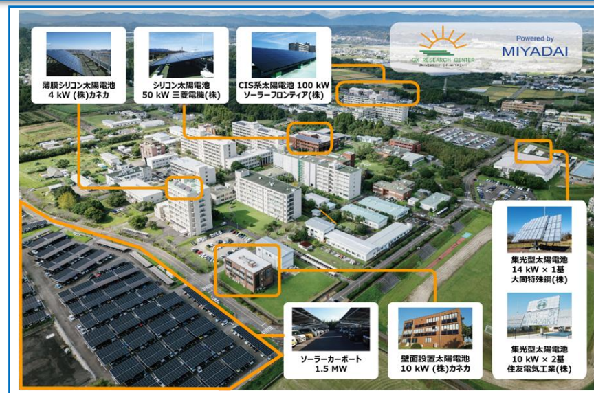
▲ 日本最大の太陽光発電システム実証設備
