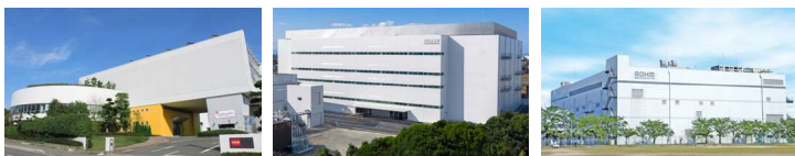
広川本社工場
