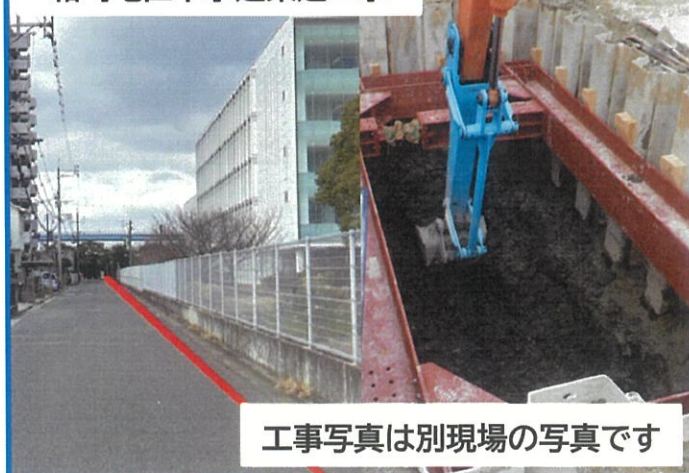
箱崎地区下水道築造工事
