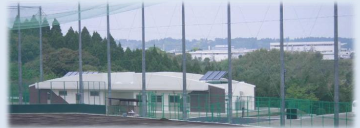
新設した多目的グラウンド
