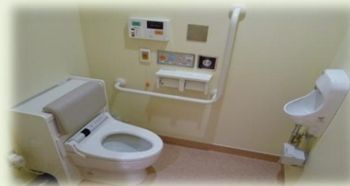
新病棟に導入した節水型便器
