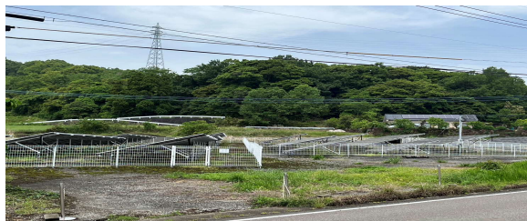
太陽光パネル
