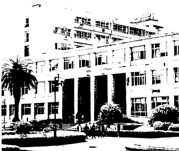
▲現在の農学部棟正面（奥は研究棟）
