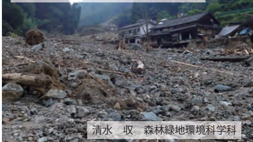
2017年の九州北部豪雨の際、福岡県朝倉市で発生した大きな土砂災害
