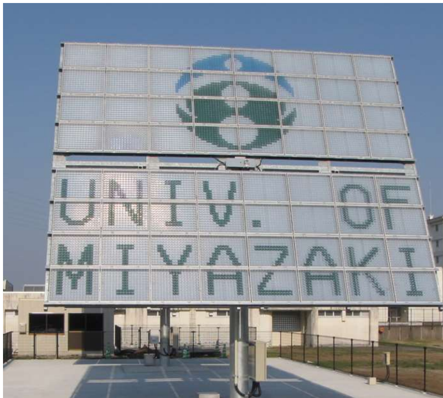
図 3(c). 宮崎大学に設置してある集光型太陽光発電システム
