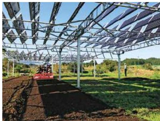
営農型発電（ソーラーシェアリング）システムは、農地の上空に設置した太陽光発電設備で発電し、地上では農作物を生産するハイブリッドな農業システムです。
