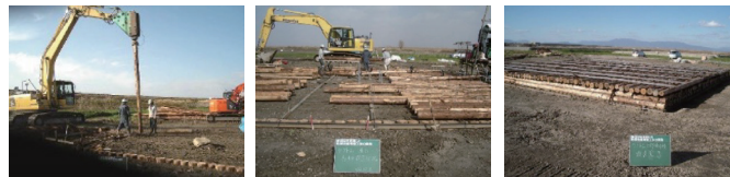
筏と列杭基礎の実施工事実験
