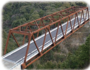
山間部に建設されることが多い 耐候性鋼橋梁
