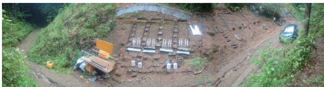
簡易治山工を設置した実斜面区画
