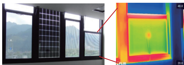
図1. 宮崎大学に設置した窓型太陽電池
