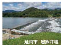
延岡市 岩熊井堰
