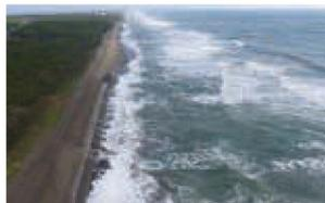
浜崖の後退を抑止するための対策技術（サンドバック）
