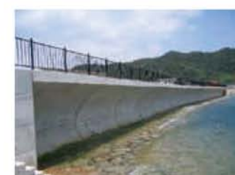
現地での施工事例
