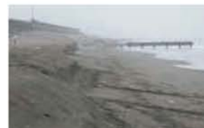
砂浜が侵食されて埋設管が露出(宮崎海岸)
