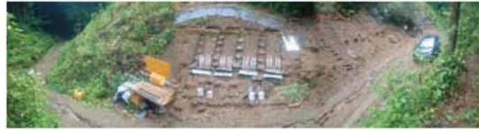
簡便治山工を設置した実斜面区画
