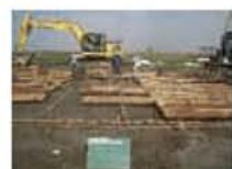
筏と列杭基礎の実施工実験
