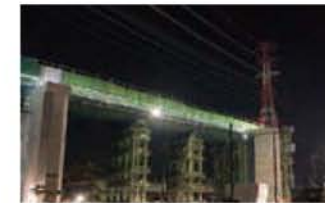
橋梁の架設見学 橋梁が線路や河川を超えて架けられる瞬間を見学
