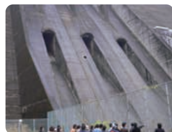
社会を支えるインフラ設備の現場見学
