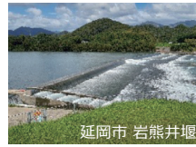
延岡市 岩熊井堰
