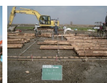
筏と列杭基礎の実施工実験
