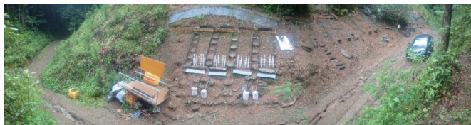
簡便治山工を設置した実斜面区画
